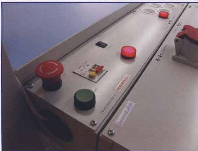
Přístroje v kabelovém kanálu
